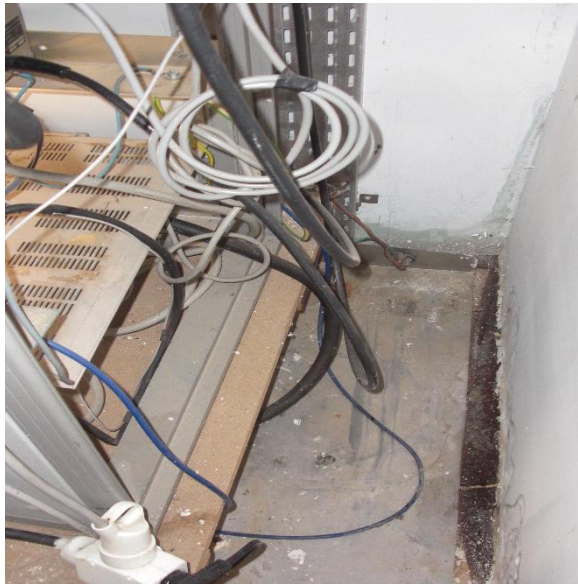
Arrière du rack, on voit la plaque au sol et le chemin de câble. Il y a aussi une câblette de terre !
