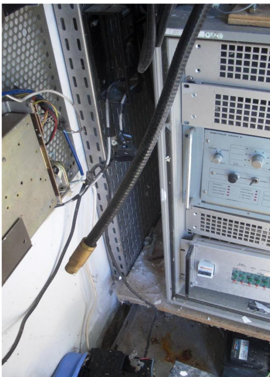
Ici, le bas du chemin de câble, au Sol, plaque. On voit l'émetteur du R4.
