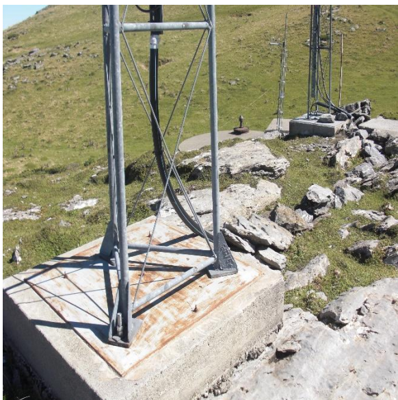
Les 2 pylônes du R4 avec les plaques sur les Massifs.
