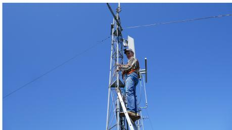
Montage du dipôle sur le pylône « émission », direction Nord, polarisation horizontale sur le montant le plus au Nord.
