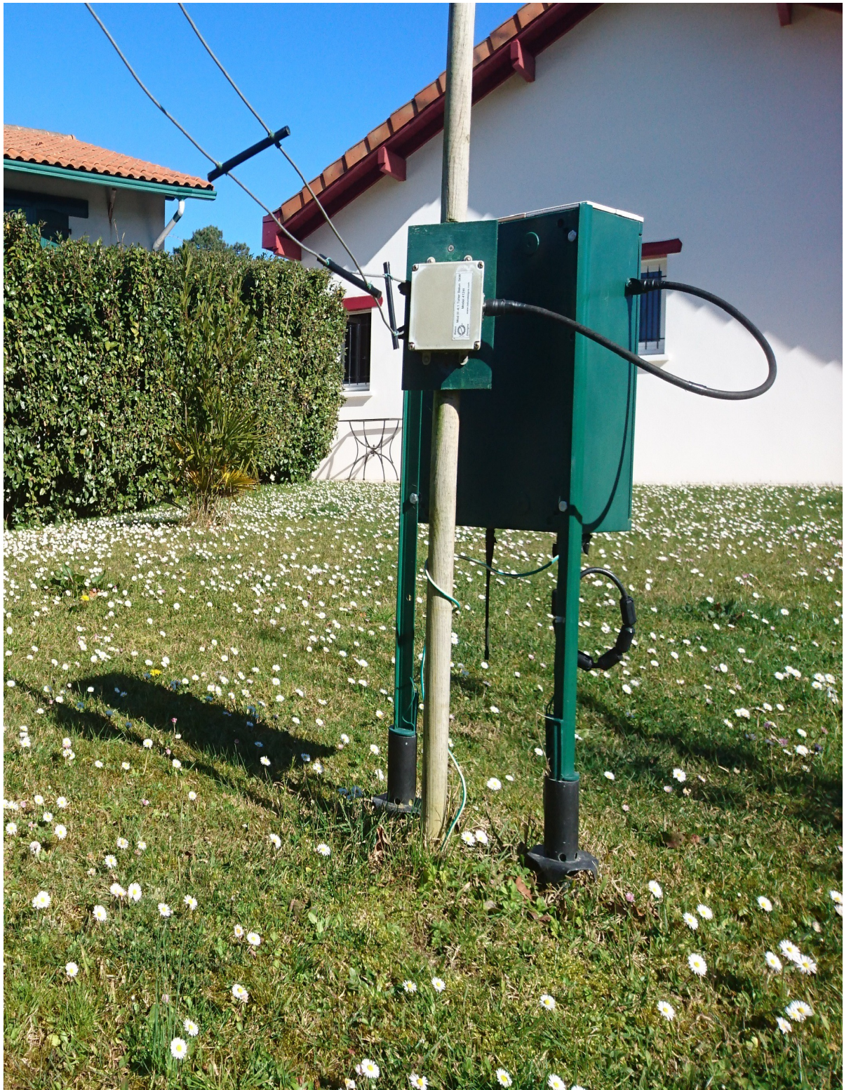
Boîtier de couplage, coax de liaison, balun 4:1 et départ feeder ouvert
