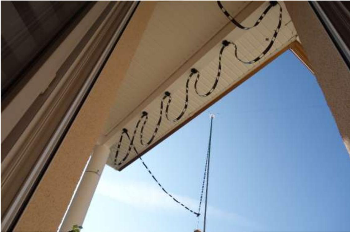
**Descente du Twin-lead sous un angle de 30 à 35°**
