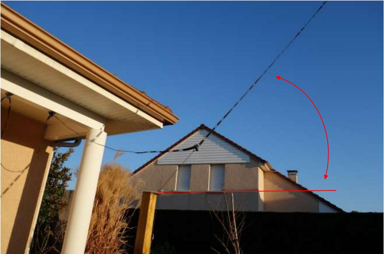
Le câble Twin-lead peut descendre sous un angle de 30 à 35 ° (pas plus) et le tendeur dynamométrique avec ressort de compensation en inox, est à définir suivant la longueur du câble; il ne doit pas excéder 10 m.
